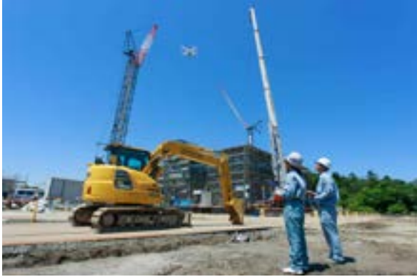
ドローンを使った建設現場
