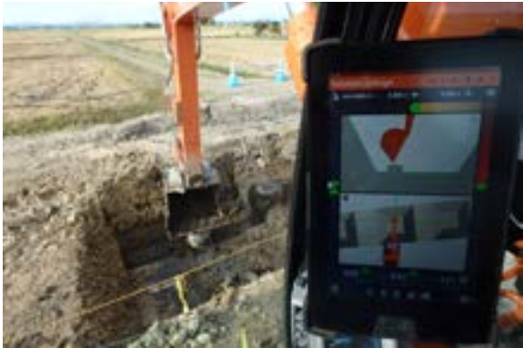
MMSやICT建機を使った道路工事
